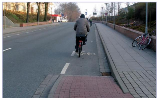
Abb.5: Einfädelung in den fließenden Verkehr (Lüneburg)
