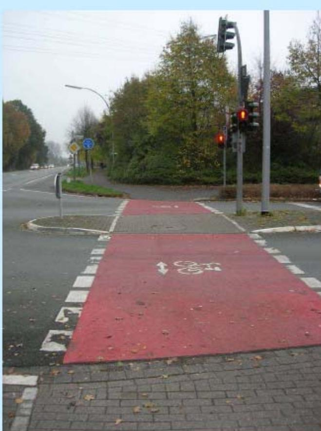
Roteinfärbung und Richtungspfeile in Furten mit Freigabe des Radverkehrs in beiden Fahrtrichtungen
