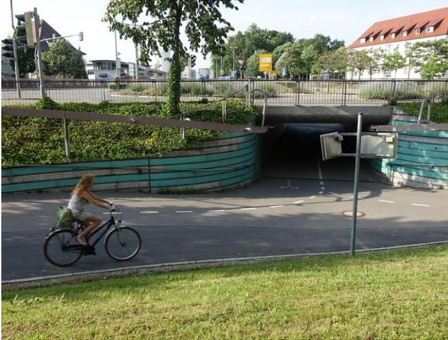
Bild 18: Durch die Aufweitung des südlichen Einfahrtsbereiches wurde die Sichtbeziehung für ein-fahrende Radfahrer erheblich verbessert. Diese Verbesserung wurde bei den Radlers Höhen und Tiefen 2016 vorgeschlagen.
