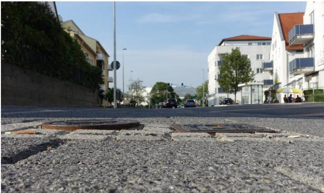
Bild 26, 27: 2016 wurde die Fahrbahn und der Geh- und Radweg der Ailinger Straße im Bereich des Knotens Goethestraße und Meistershofener Straße saniert. Der Radweg wurde mit einem Pflasterbelag versehen, der im Vergleich zu Asphalt erhebliche Nachteile aufweist:
