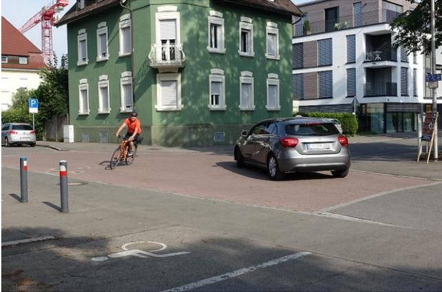
Bild 1: Von 2006 bis 2011 wurden im Rahmen des Metron-Radverkehrskonzeptes die Knoten am Schulquartier zwischen Katharinen- und Allmandstraße umgebaut und mit erhöhten Pflasterflächen gestaltet. Ziele waren insbesondere die Geschwindigkeitsreduzierung des Kfz-Verkehrs und die städtebauliche Aufwertung des Quartiers.
