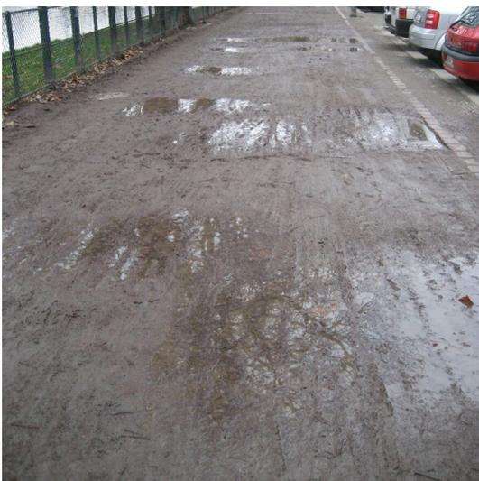
Abb. 6: Wassergebundener Weg mit starker Pfützenbildung und Fahrradspuren am Landwehrkanal in Kreuzberg.
