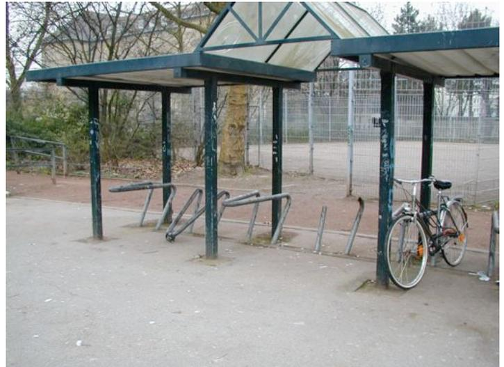
**Abbildung A2.23: Beschädigte Leinebügel am S-Bahnhof Rath Mitte**
