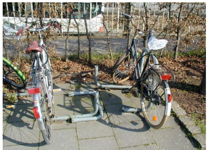
**Abbildung A2.10: Verletzungsgefahr durch beschädigte Spiralbügel am Bonner Hauptbahnhof**
