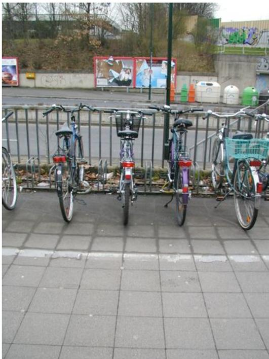
**Abbildung 4.9: Schlechter Wirkungsgrad der Vorderradhalter am S-Bahn-hof Hellerhof**
