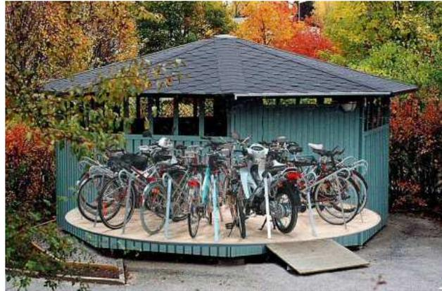
Karussellartige Fahrradboxen: Fahrräder werden auf einer von Hand drehbaren Plattform abgestellt, die das Fahrrad vor die Eingangstür dreht
