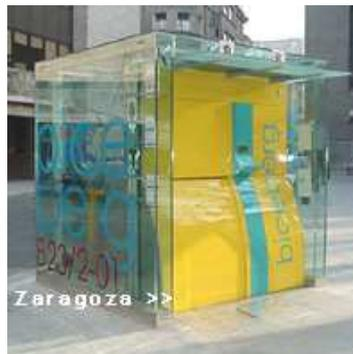
*Biceberg: voll automatische unterirdische Fahrradparkanlage in Form einer großen horizontalen Mühle. Sie ist in Modulen für 23, 46, 69, oder 92 Fahrrädern erhältlich. In Spanien wurden bereits unterschiedliche Typen aufgestellt.*
