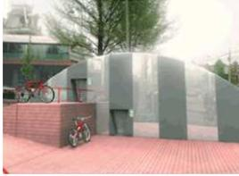
Fahrradmühle in Nieuw-Vennep in den Niederlanden: unterirdische Parkanlage für 200 Fahrräder in Form einer großen Mühle, 3 m über- und 9 m unterirdisch.
