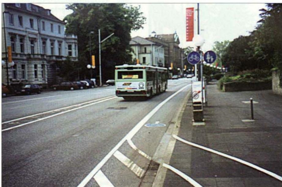
Bild 9: Überbreite Richtungsfahrstreifen mit Radfahrstreifen (Bonn)
