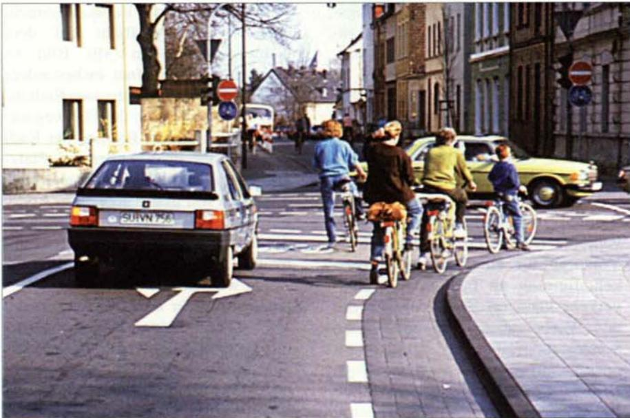
Bild 5: Radspur mit aufgeweitetem Radaufstellstreifen (Troisdorf)
