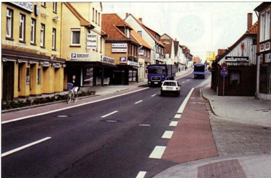
Bild 8: Engstelle mit schmalen Radverkehrstreifen und eingengter Fahrbahn (Walsrode)
