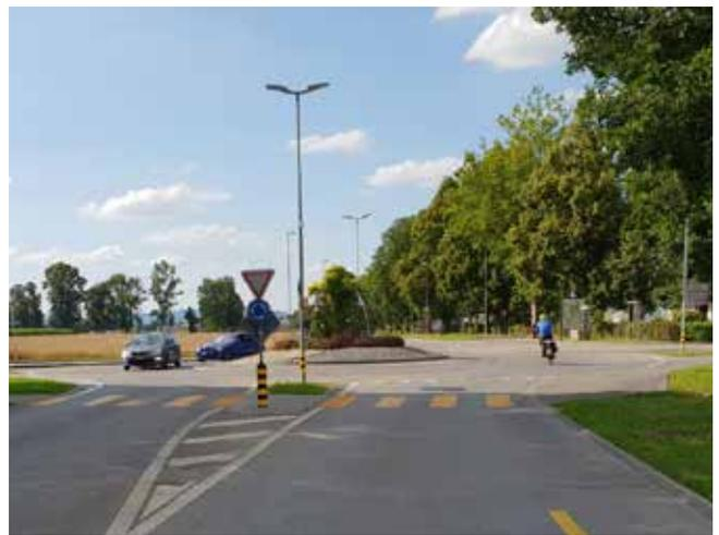
Abb. 4: Kreisel in Thun mit zu breiten Einfahrten und zu breiter Kreisfahrbahn sowie sich überschneidenden MIV- und Velo-Achsen. (Bürgerstrasse - Allmendingenallee, Sanierungsprojekt durch B+S AG in Erarbeitung).
