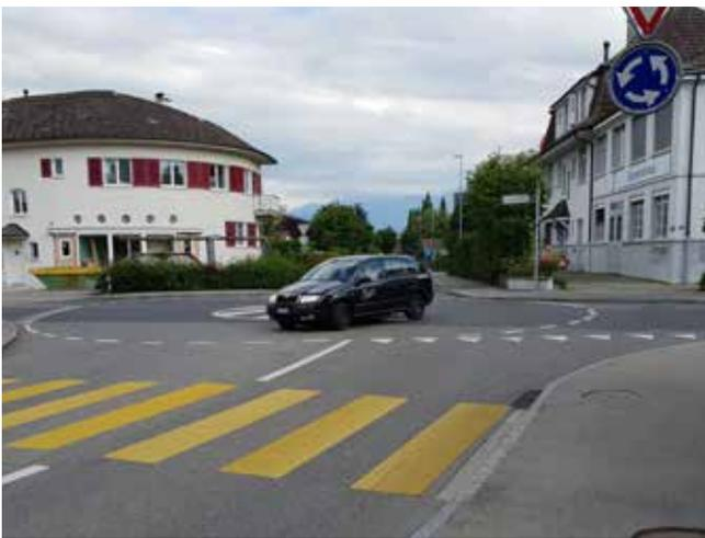
Abb. 3: Minikreisel mit einem zu einfach überfahrbaren Innenring (Mattenstrasse - Länggasse in Thun, Sanierungsprojekt durch B+S AG in Erarbeitung).
