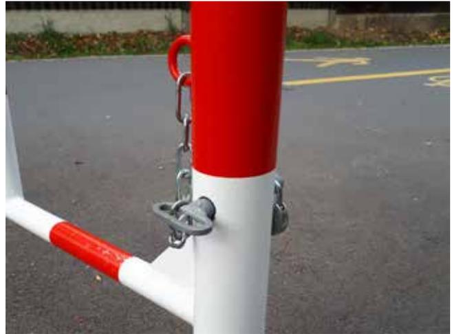
Abb. 5: Detail der Verriegelung des drehbaren Schrankenelements
