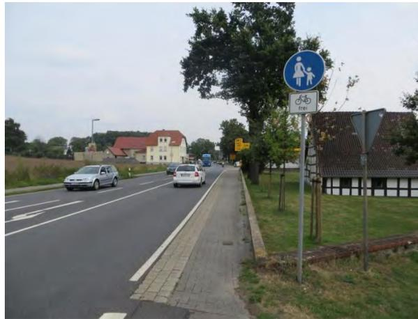
In Belm wird der Radverkehr häufig auf Gehwegen mit dem Zusatz „Radfahrer frei“ geführt. Eine gemeinsame Führung von Fuß- und Radverkehr ist nur in Ausnahmefällen zulässig.
