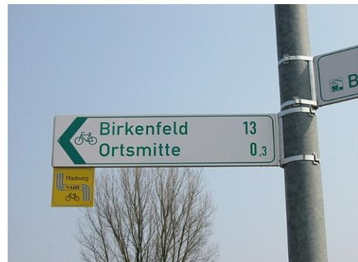
Die Befestigung der Wegweiser hängt vom Wegweisertyp und von der Art des Pfostens ab.
