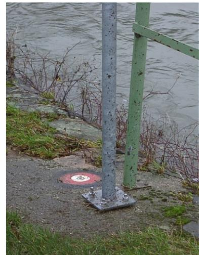
Fußplatte; Untergrund Beton
