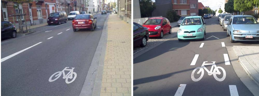
Vorgeschlagener Fahrradbereich und vorgeschlagener Fahrradbereich entgegen der Fahrtrichtung (Bildquelle: D. Dufour)
