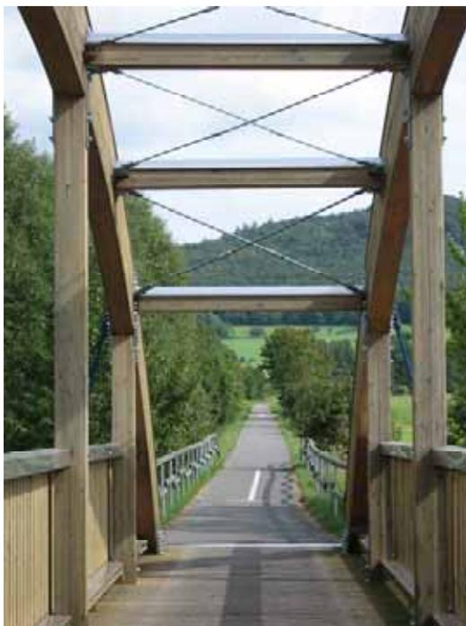
Beispiel für eine neu erbaute Holzbrücke für den Radverkehr. Der Holzbelag ist stark strukturiert und wirkt rutschhemmend (Milseburgradweg).
