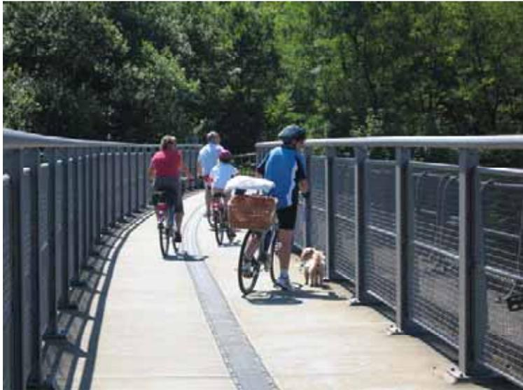
Beispiel für ein altes Viadukt. Ein neues stark erhöhtes Gelände wurde direkt neben der Fahrbahn angebracht und ist vom Tal aus kaum sichtbar. Das alte historische Gelände blieb erhalten. Die Fahrbahn hat eine Mittelrinnenentwässerung (Maare-Mosel-Radweg).
