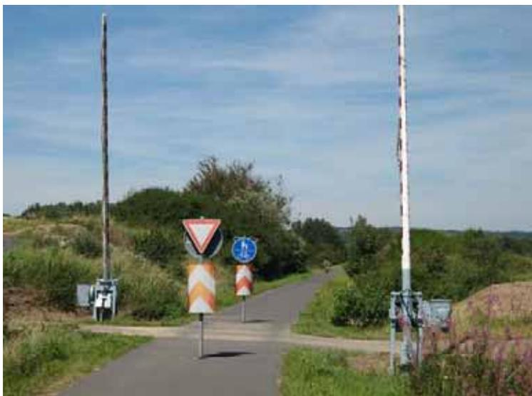
B) Beispiel für eine Querungsstelle, bei der der Absperrpfosten durch eine Bake ersetzt wurde. Es fehlen ggf. noch die seitlichen Pfosten zur Verhinderung von unerwünschtem Autoverkehr. Die Schranke ist ein bahnhistorisches Element und dient zur Dekoration des Radweges (Milseburgradweg).
