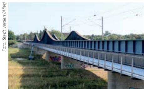
Die neue Radbrücke wurde mit Stahlbetonplatten direkt an die Allerbrücke montiert.
