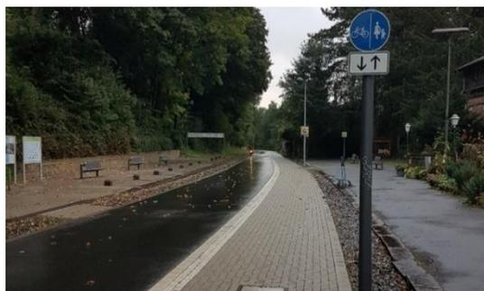
Abbildung 12 Selbstständiger Geh- und Radweg mit optisch kontrastierender taktiler Trennung (Wuppertal Nordbahntrasse) (Foto: IVST)
