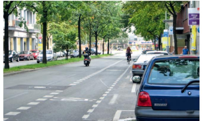
Als Pilotprojekt wurden in beidseitig eng angebauten Straßenabschnitten die Flächen des Kfz-Verkehrs zugunsten von Angebotsstreifen auf der Fahrbahn reduziert und der Kfz-Verkehr in der Fahrbahnmittte gebündelt. Durch das Abrücken der Fahrspuren von den Wohnhäusern sinkt dort die Lärmbelastung. Dieser Ansatz wurde an drei Beispielstrecken in der Praxis getestet: Brandenburgische Straße in Charlottenburg-Wilmersdorf, Dudenstraße in Friedrichshain-Kreuzberg und Prinzenallee in Mitte.
