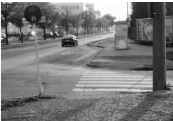
Gleich nach der Kreuzung ist eine Bushaltestelle, nach der Bushaltestelle ist die Auffahrtsrampe schräg ausgeprägt. Diese Rampenform ist gefährlich (Sturzgefahr) und unkomfortabel (erzwingt
