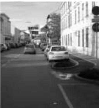
Hier ist die Abzweigung von der Fahrbahn auf den Radweg in einem zu steilen Winkel ausgeführt, das wirkt bremsend (siehe Foto links).
