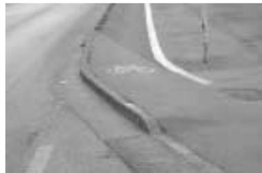
Drei Hauptfehler bei Rampen: zu steil (links), zu niedrig (Stufe, mitte), schräg zur Fahrtrichtung
