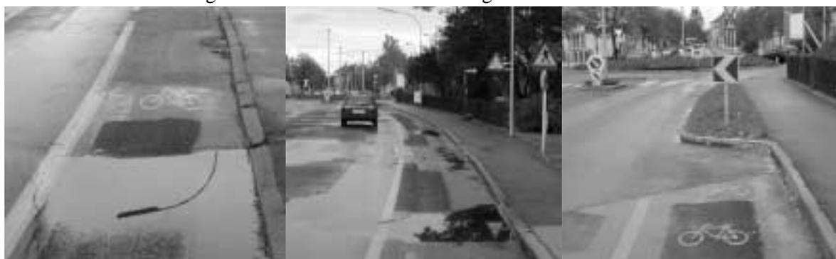
Gleich nach der Pöckgasse demonstrieren Wasserlacken, wie uneben der Radstreifen hier ist. Auch auf Höhe der Ausfahrt vom Studentenheim (Bild oben Mitte) bleibt nach einem Regen eine störende Lacke. Die anderen Unebenheiten auf diesem Radstreifen wurden jedoch im Laufe des heurigen Jahres im Zuge diverser Bautätigkeiten sehr gut beseitigt.
