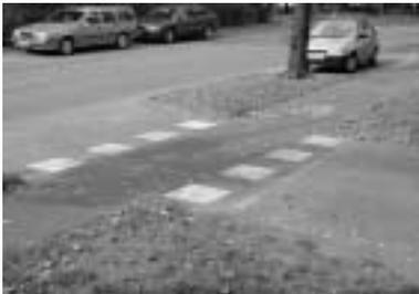
In dieser Fahrtrichtung stören Aufwölbungen im Asphalt. Dies sollte bei nächster Gelegenheit behoben werden. Auf der Höhe von Haus Nr. 7 ist eine Radwegabsenkung wegen einer Parkplatzausfahrt (siehe Bild links). Wie so oft in solchen Fällen plädiert DINAMo dafür, den Radweg am selben Niveau durchzuführen.
