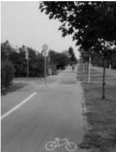
da es sich um einen Zweirichtungsradweg handelt. Durch den Niveauunterschied für die querenden Fahrzeuge ergibt sich eine Temporeduktion, die ungewohnte Situation für die Autofahrer, Radfahrer aus beiden Richtungen zu erwarten, ist somit entschärft.
