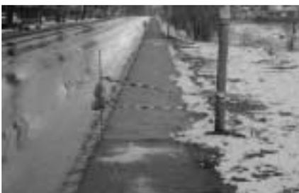
Bei Bauarbeiten am Radweg, bei denen der Belag entfernt wird, sollte so rasch als möglich neuer Belag aufgebracht werden. Ein "Schotterbelag" sollte nicht länger als unbedingt notwendig auf einer solchen Stelle sein.
