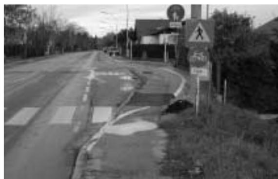
Kurz vor der Neufeldergasse kommt aufgrund der Bushaltestelle eine scharfe Kurve für Radfahrer, und gleich danach eine Bodenwelle. Hier sollten die Belagsunebenheiten ausgebessert und die Linienführung geändert werden (Foto rechts).
