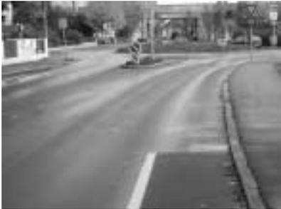
**Gut ausgeführter Übergang vom Radstreifen in den Kreisverkehr**
