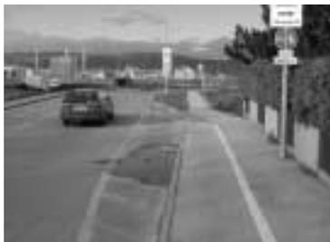
Die Einmündung vor dem Kreisverkehr (Kreuzung mit Zehnergürtel, siehe Bild links) ist etwas abrupt gestaltet. Eine etwas "sanftere" Linienführung ist hier wünschenswert, damit die Radfahrer sich zügig in den Verkehr einordnen und durch den Kreisverkehr fahren können.
