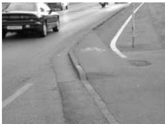
Temporeduktion der Radfahrer). Darüber hinaus ist die Rampe im linken Bereich viel zu steil. Eine flachere Rampenform in Fahrtrichtung ist hier deutlich sicherer und zweckmäßiger. Diese Rampenform sollte umgehend geändert werden!
