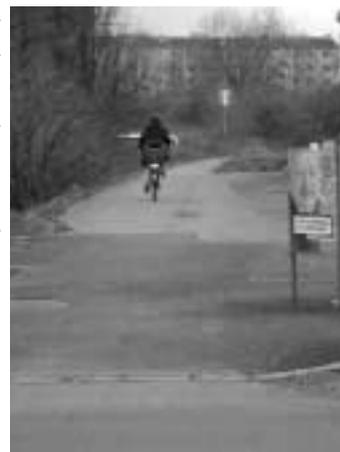
Gleich nach dem Zebrastreifen senkt sich der Radweg auf Fahrbahnniveau, sodaß die Radfahrer sich gut einfädeln können vor dem kleinen Kreisverkehr (Höhe Rudolf Kumbain Gasse). Nach diesem Kreisverkehr ist die Auffahrt auf den Radweg wieder etwas abrupt, zu schräg zur Fahrtrichtung. Auch diese Rampe sollte dahingehend geändert werden, daß ein Auffahren auf den Radweg nicht schräg zur Fahrtrichtung erfolgen muß.
