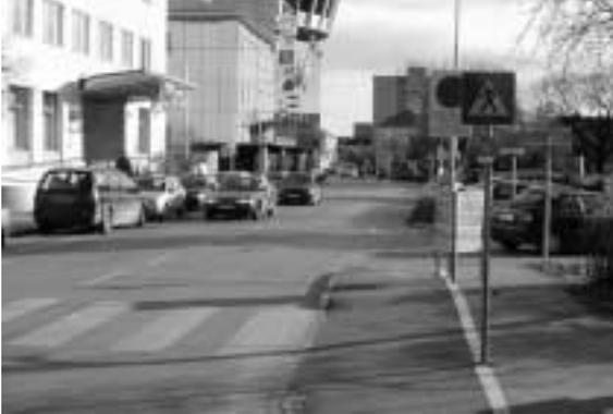
Vor der Fahrschule ist wieder eine "Hochschaubahn", da der Gehweg/Radweg für die Ausfahrt der Fahrschule abgesenkt wird, danach wieder auf das ursprüngliche Niveau hinaufgeht, um sich wenige Meter später am Ende wieder auf Fahrbahnniveau abzusenken (siehe Foto links). Hier sollte entweder der Gehweg/Radweg auf gleichbleibendem Niveau durchgezogen werden, oder der "Zwischenhügel" entfernt werden. Der Radwegverlauf bei Beginn des Johann-von-Nepomuk-Platzes ist unklar. Hier ist eine unter-
