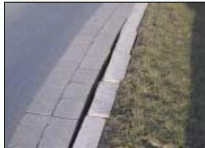
Bild 6: Schaden am Bord im Bereich der Verziehung
