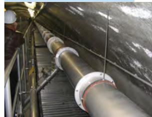
Betonröhre mit Lamellenabscheider
