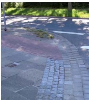
Zur Erhöhung des Fahrkomforts wurden alle infrage kommenden Bordsteine abgesenkt oder mit einem Asphaltkeil versehen. Bei Absenkungen werden die Tiefbordsteine durch eine Gossenreihe ersetzt und im daneben liegenden Gehweg
