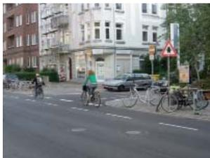
In diesem Abschnitt der Olshausenstraße wurden schmale gebaute Radwege durch 1,60 m breite Schutzstreifen in der Fahrbahn ersetzt. An den Einmündungen zu den Nebenstraßen wurden
