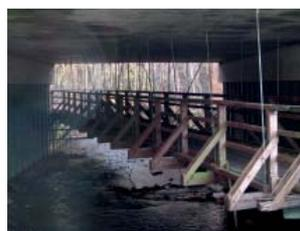
Zur Vernetzung von Naherholungsgebieten und Freizeitrou-ten wurde bei der Sanierung einer Straßenbrücke über den Hasenburger Bach eine Geh- und Radwegkonstruktion untergehängt.
