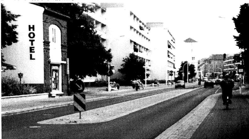
Während Fußgängerfurten- und überwege überwiegend an Kreuzungen und Einmündungen eingesetzt werden, kann durch Querungshilfen die Trennwirkung von Straßen – insbesondere mit starker Wohn- und Geschäftsnutzung – reduziert werden. Je nach Straßentyp sind Abstände von 100 bis 250 Metern möglich.
