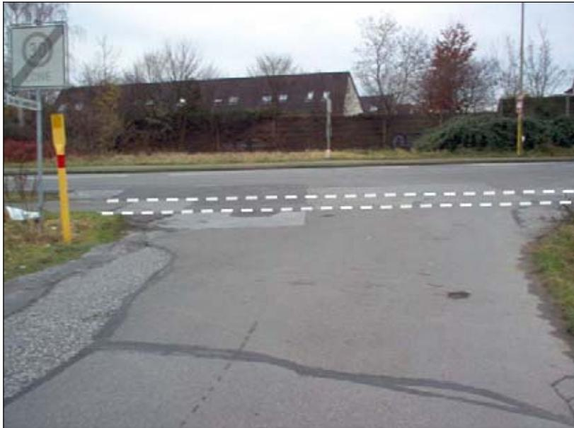
Abb. 42: Markierung des Fuß- und Radweges mittels weißer unterbrochener Linie
