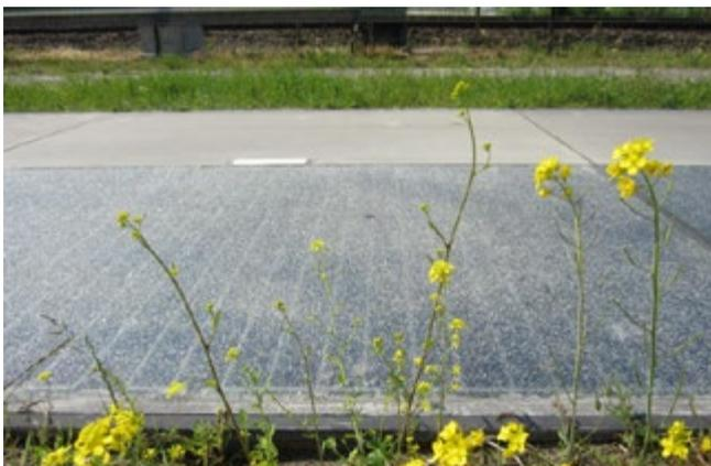
Abbildung 20: Solarstromerzeugung mit Radweg (Pilotprojekt „SolaRoad“ Zaanstad/NL)
