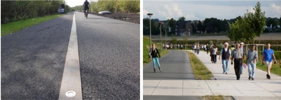
Abbildung 8: Möglichkeiten der Trennung von Rad- und Fußverkehr<sup>9</sup>
