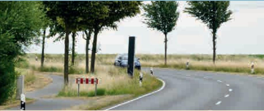
Verschwenkungen oder unvorhersehbare Hindernisse werden für Radfahrende durch Baken deutlich gesichert.
