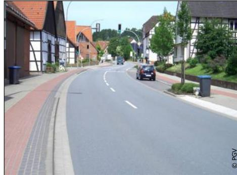
Bauliche Radwege im Seitenraum gewährleisten sowohl subjektiv als auch objektiv eine verkehrssichere Führung sofern die Sicherheits- und Qualitätsstandards eingehalten werden. Die Regelbreite von baulichen Radwegen beträgt 2,00 m, bei geringer Radverkehrsstärke kann eine Breite von 1,60 m genügen.
