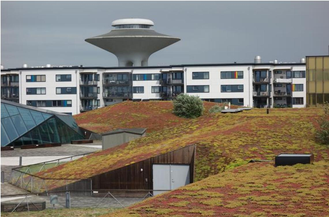
Abb. 74: Referenzbild Dachbegrünung: Emporia, Malmö – öffentlich zugänglicher Dachgarten des Einkaufszentrums, vorne mit extensiver und hinten zusätzlich auch intensiver Dachbegrünung (Herbert Brüning)
