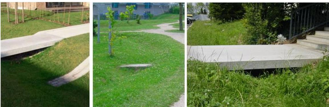
Abb. 66: Referenzbilder Versickerung mit Bodenpassage: Kleiner Horst, Hamburg (links); Scharnhäuser Park, Ostfildern (Mitte und rechts) (Ramboll Studio Dreiseitl)
