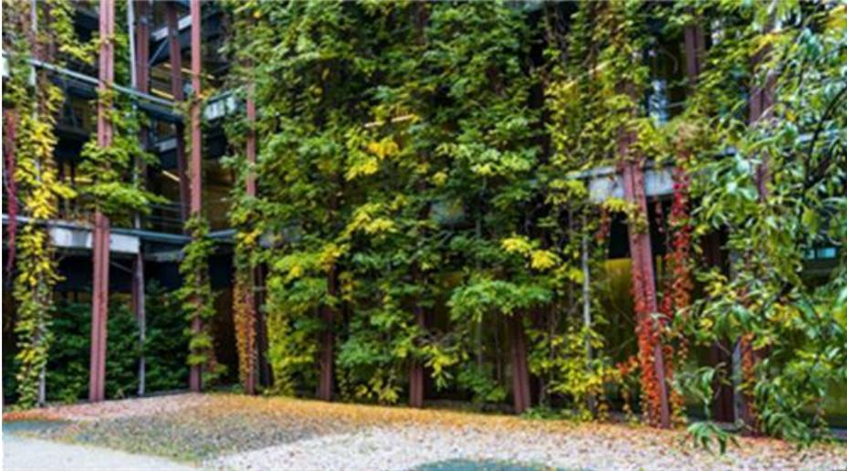
Abb. 76: Referenzbild Fassaden-/Wandbegrünung: Physikgebäude der Humboldt-Universität in Berlin-Adlershof – Gebäudebegrünung mit Hilfe vertikal angeordneter Pflanzkübel, die im Anstauverfahren bewässert werden (KWB 2018)
