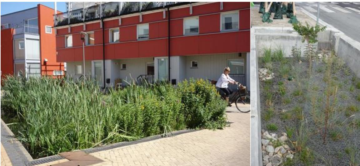
Abb. 68: Referenzbilder Tiefbeet: Malmö, Västra Hamnen; die Straßenentwässerung wird mit einer Reinigung durch Pflanzen in Tiefbeeten kombiniert, im rechten Bild ist im frisch bepflanzen Tiefbeet hinten der Überlauf gut zu erkennen (Herbert Brüning)
