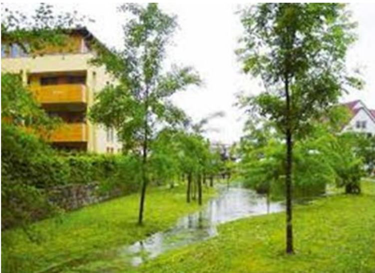
Abb. 67: Referenzbild Verdunstungsmulde mit einer maximalen Einstauftiefe für den Regenwasserrückhalt von 30 cm: Arkadien, Winnenden (Ramboll Studio Dreiseitl)
