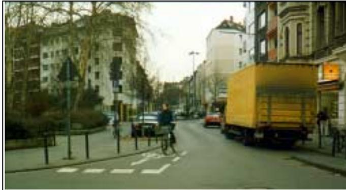
Bild 11: Markierung einer "Ausfahrttasche" mit Wartelinie für gegengerichteten Radverkehr an einem rechts-vor-links geregelten Knotenpunkt (Köln)
