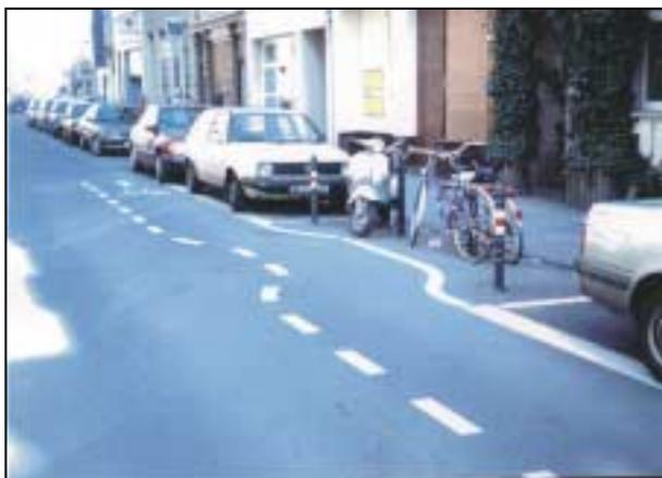
Bild 9: Markierung einer Ausweichstelle für Begegnungen in einer Einbahnstraße mit schmaler Fahrgasse (Köln)
