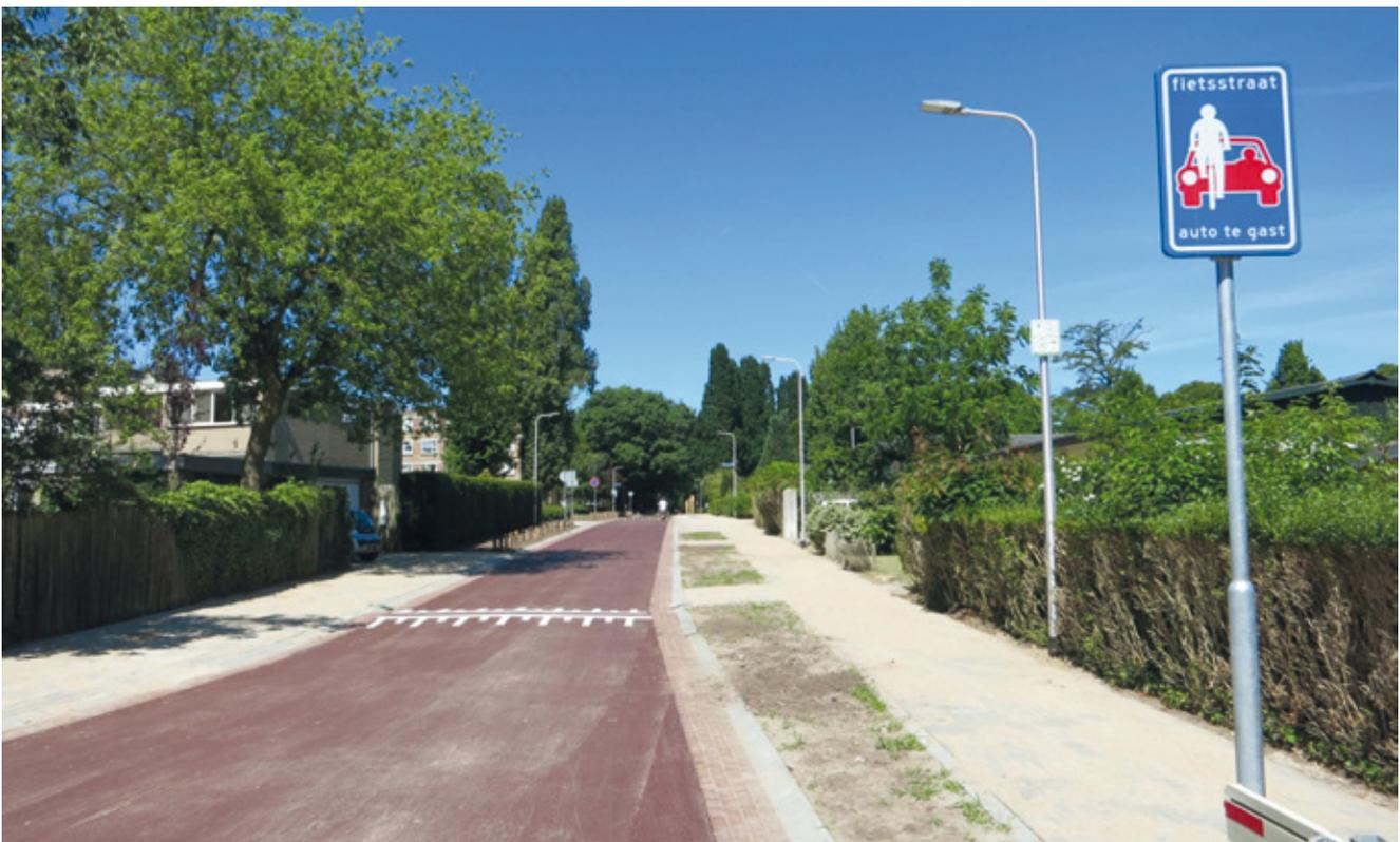
Velostrasse in Nijmegen (NL) mit dem weit verbreiteten Signal mit Aufschrift «auto te gast» (Auto zu Gast) und mit flächig rotem Belag; velotaugliche Schwellen dienen als Beruhigungsmassnahme.
