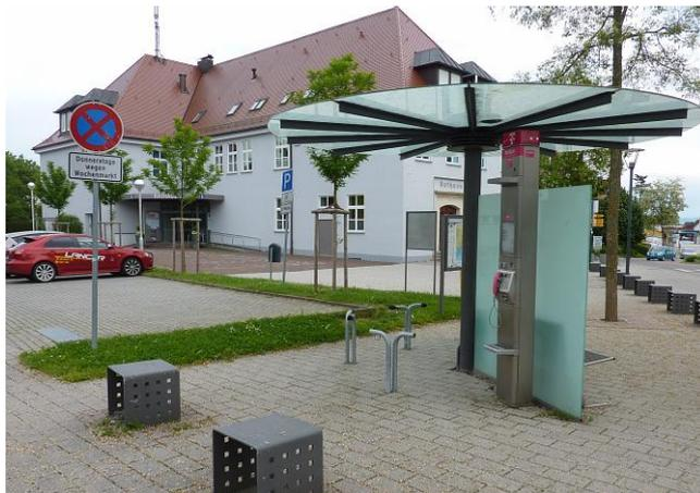
Bild 55: Am Vorplatz sind sechs Rahmenhalter vorhanden, von denen zwei nicht benutzbar sind. Für viele moderne Fahrradtypen, z.B. Pedelecs, sind diese Rahmenhalter nicht geeignet. Die Überdachung der Fahrradständer ist nicht ausreichend.
