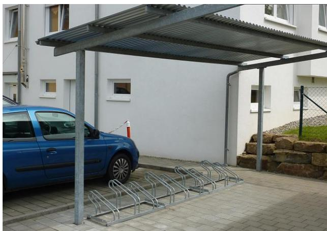
Bild 60: Die Abstellanlage des Gebäudes Haldenweg 2 entspricht wegen der vorhandenen Vorderradhalter („Felgenklemmer“) nicht den Vorgaben der Fahrrad-Stellplatzrichtlinie.
