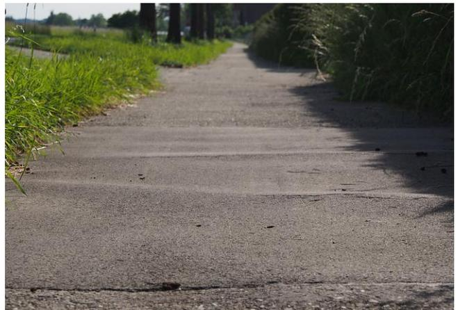
Bild 35: Es sind auf dem gesamten Streckenabschnitt bis Kehlen erhebliche Belagsmängel durch Wurzelaufrüche und Welligkeiten vorhanden. Dieser Radweg weist bezüglich der Oberflächenqualität die schlechteste Qualität im gesamten Stadtgebiet Friedrichshafens auf. Auch dieser Radweg ist durch Bewuchs in seiner nutzbaren Breite stark eingeschränkt.
