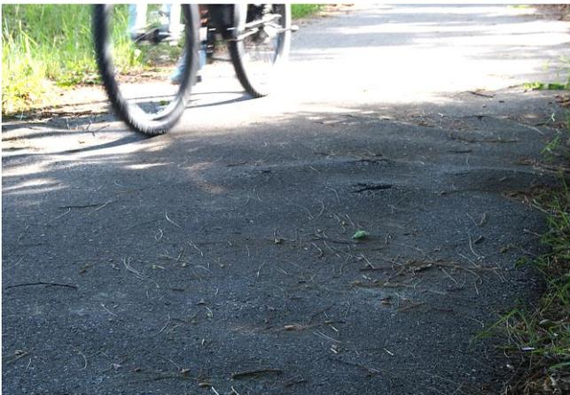
Bild 34: Beim Radweg an der Habratsweiler Straße sind einzelne größere Belagsmängel durch Wurzelaufrüche vorhanden. Der Radweg ist außerdem durch starken Bewuchs von angrenzenden Hecken öfters in seiner nutzbaren Breite stark eingeschränkt.
