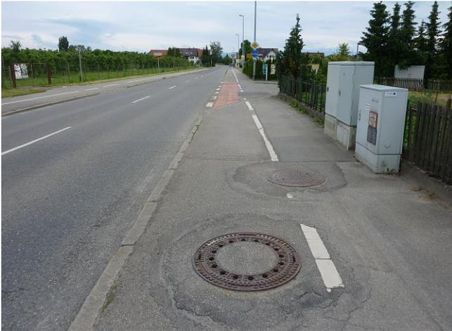
Bild 32: Der Radweg ist durch zahlreiche Asphaltarbeiten in einem sehr schlechten Zustand. Eine durchgehende Belagsanierung oder alternativ eine Führung des Radverkehrs auf der Fahrbahn ist dringend erforderlich.
