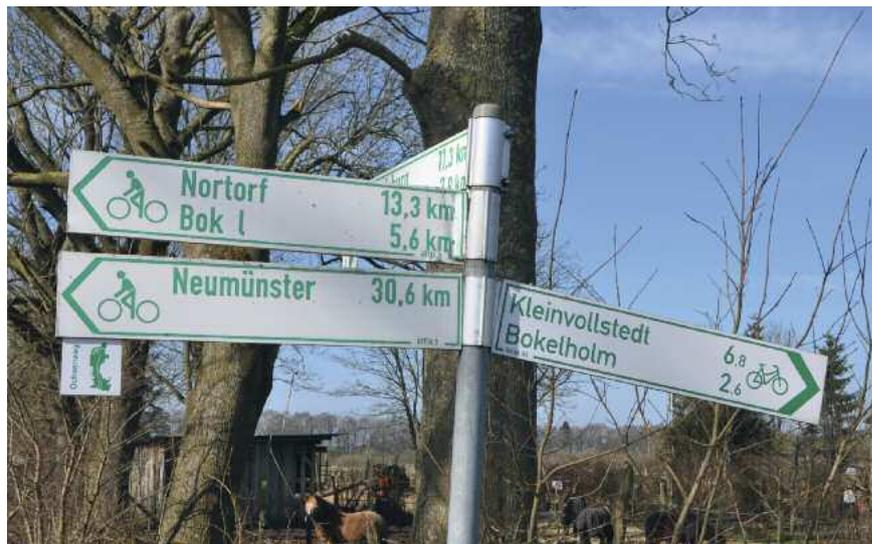
Der rechte und der linke obere Armwegweiser sind lose und müssen neu befestigt werden. Wenn dies unterbleibt, werden sie sich weiter lockern und nach einiger Zeit herunterfallen. In der Regel müssen sie dann komplett ersetzt werden.
