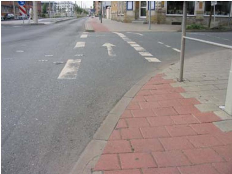
**Bild 13: Knoten Reichsstraße/Schmelzhüttenstraße mit in Bereich des Radweges auf 0 cm Auftrittshöhe abgesenkten Bord**
