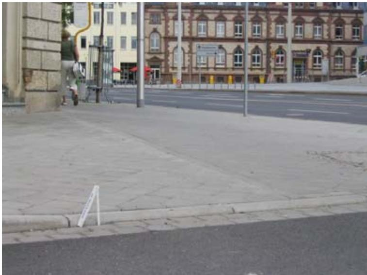
**Bild 12: Neu gebaute Bordabsenkung an der Einmündung der Neuen Straße in die De-Smit-Straße (Ostseite)**
