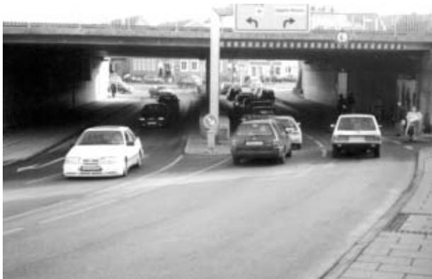
**Vorher:** Die zwei Fahrspuren in der linken Hälfte der Unterführung wurden vom Kfz-Verkehr nicht gebraucht, da nur einspurig in die Unterführung eingefahren werden konnte. Für den Radverkehr bestanden beidseitige Geh-/ Radwege, und durch die umständliche Radverkehrsführung waren Geisterradfahrer in der Unterführung an der Tagesordnung. Eine hohe Unfallquote war die Folge.
