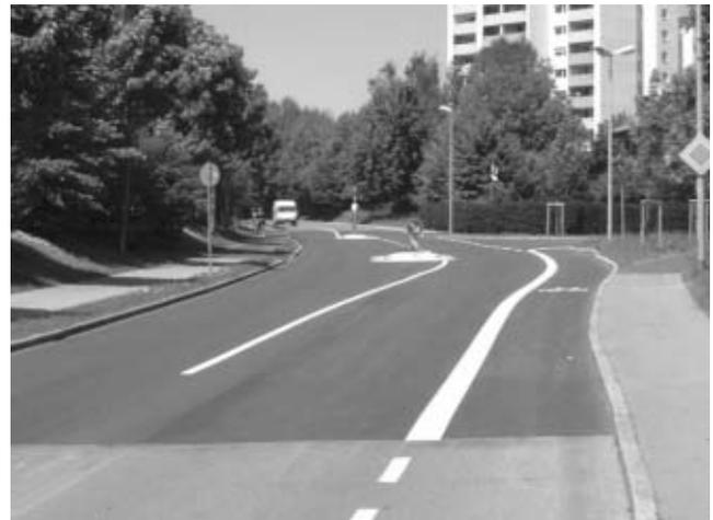
**Nachher:** Die Fahrbahnen wurden sichtlich verschmälert. Die zwei Querungsiseln bringen zusätzliche Aufmerksamkeit auf das Umfeld der Einmündung und verringern so die Geschwindigkeit. Ein schnelles Abbiegen ist nicht mehr möglich. Radfahrer werden eindeutig geleitet und haben eine gesicherte Quermöglichkeit auf den linken Radweg.
