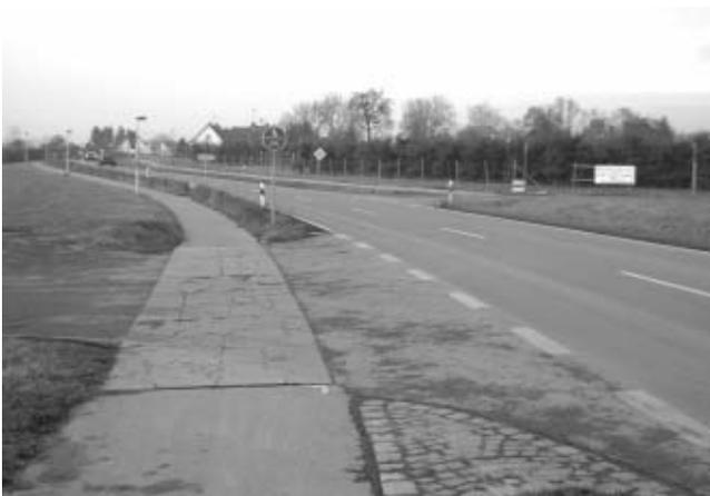
**Klufturner Straße:** An den Einmündungen nach Eichenmühle (links) und Riedern (rechts) schlägt Metron eine Mittelinsel vor, um die Querung zu erleichtern. Diese Maßnahme hat auch aufgrund der hier geplanten B31 geringe Realisierungschancen.
