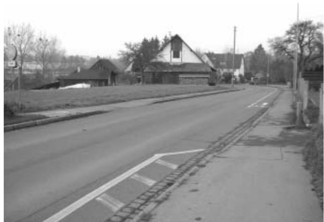
**Efrizweiler, Ortsbeginn Süd:** Links ist die vorhandene Absenkung des bestehenden Beidrichtungsradweges zu sehen, rechts befindet sich die neu geschaffene Ausleitung auf den Schutzstreifen für Radverkehr aus Riedern.
