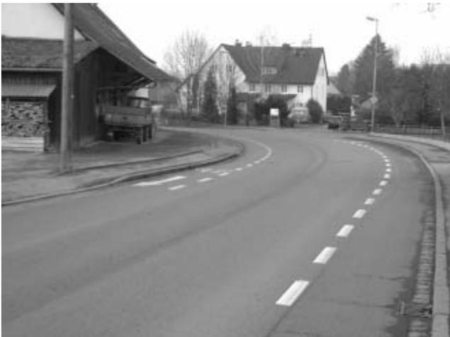
**Ortsdurchfahrt, Blick Richtung Norden (E2):** Die wechselnde Fahrbahnbreite erlaubt teilweise nur einseitige Schutzstreifen. Durch einen geschickten Wechsel und die Anpassung an die Fahrbedürfnisse von Radfahrern konnte die südliche Ortsdurchfahrt von Efrizweiler für den Radverkehr verbessert werden.
