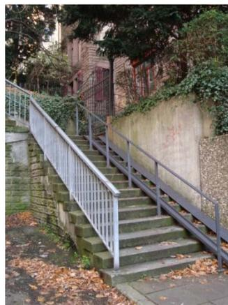
Abb. 12: **Schieberillen für Fahrräder in Stuttgart.**
