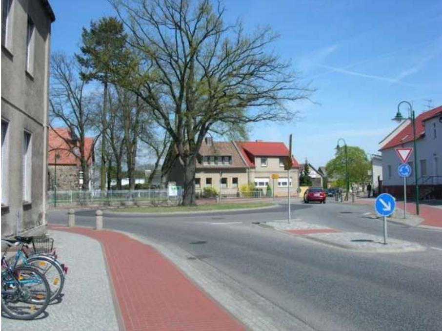
Bild 61: Kleiner Kreisverkehr mit integriertem altem Baumbestand (Hennickendorf)
