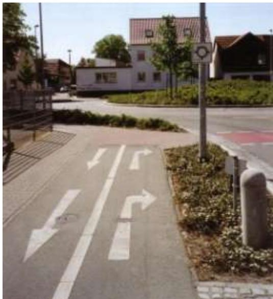
Bild 59: Markierung der Radwegeinführung in einen Kreisverkehr (Rathenow, Semliner Straße)
