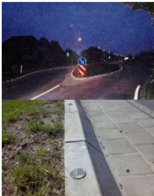
Bild 79: Verdeutlichung der Fahrbahnführung durch Glasmarker
