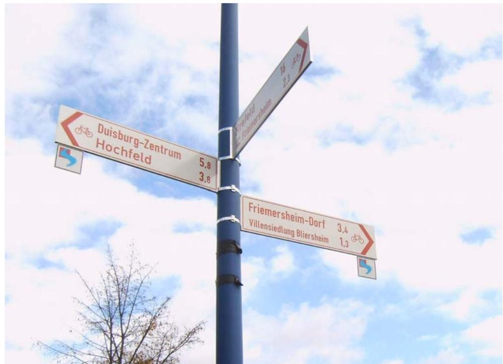
Abb. 3-28: *Bessere Sichtbarkeit: Montage eines Wegweisers an Straßenleuchte*
