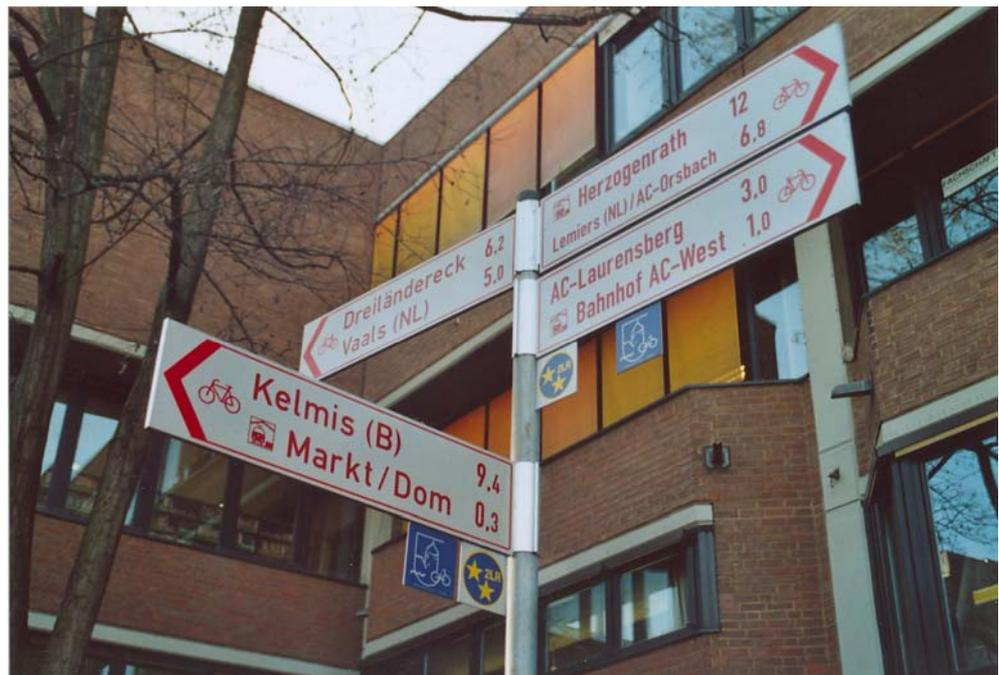
Abb. 3-18: Beispiel der Montagereihenfolge mehrerer Pfeilwegweiser, die in dieselbe Richtung weisen
