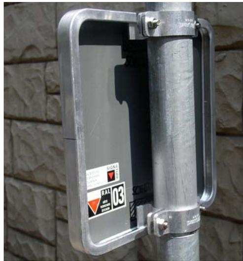
Abb. 3-33: Vandalismussichere Befestigung eines Zwischenwegweisers
