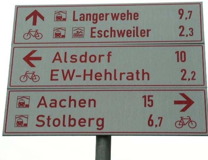
Abb. 3-17: Beispiel der Montagereihenfolge mehrerer Tabellenwegweiser nach Richtung (rechtsweisender Pfeil am rechten Rand des Wegweisers)
