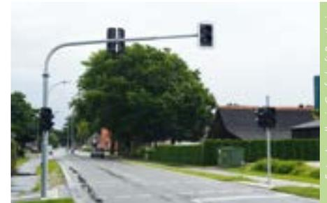
Dunkelampeln in der Grafschaft Bentheim zeigen für den Fuß- und Radverkehr kein Dauerrot, können aber bei Bedarf ausgelöst werden.
