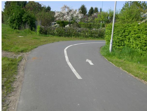
Abb. 39 Richtungstrennung durch Markierung im Kurvenbereich: Hannover
