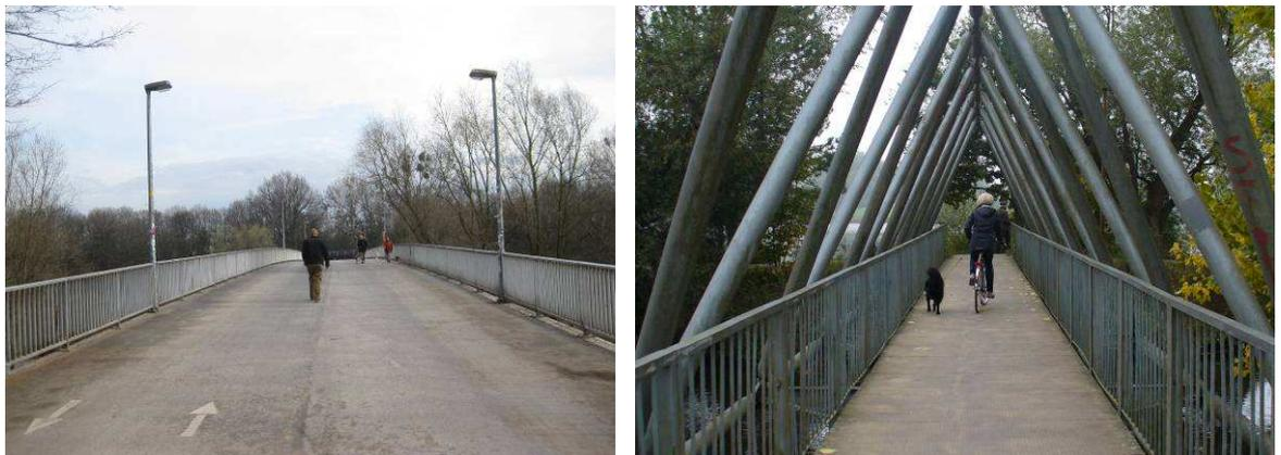
Abb. 44 Brücken für den Radverkehr im Zuge von Radschnellwegen: mit ausreichender bzw. zu geringer Breite: Hannover (links), Braunschweig (rechts)
