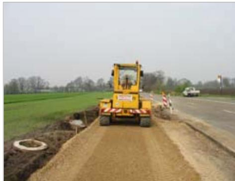
Der Leitungsgraben wurde mit Sand verfüllt und der Radweg mit Schotter vorprofiliert. Den Bau des Radweges in Asphaltbauweise übernahm der Interessenverein Uffeln e. V. Die Finanzierung des Radweges wurde durch den Landesbetrieb Straßenbau NRW aus Mitteln des innovativen Radwegebaues, durch Spenden der anliegenden Firmen, durch finanzielle Unterstützung der Stadt Ibbenbüren und mit Geldmitteln des Interessenvereins
