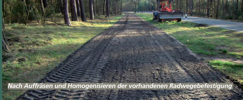
Nach Auffräsen und Homogenisieren der vorhandenen Radwegbefestigung
