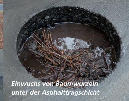
Einwuchs von Baumwurzeln unter der Asphalttragschicht
