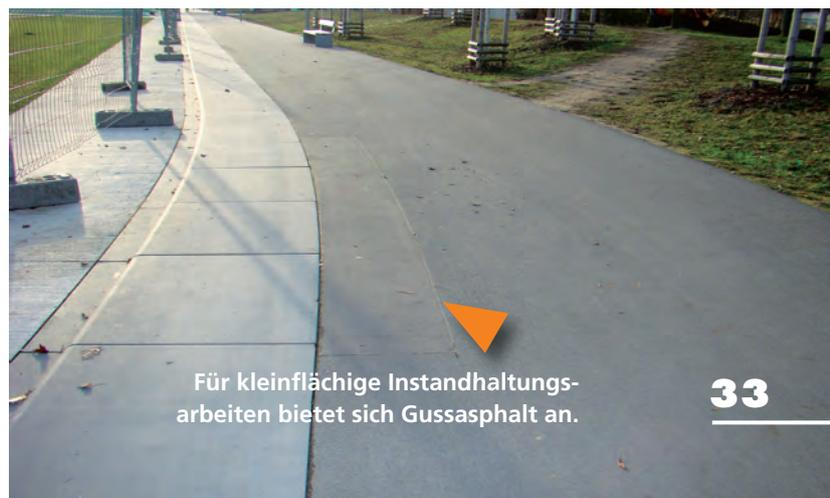
Für kleinflächige Instandhaltungsarbeiten bietet sich Gussasphalt an.
