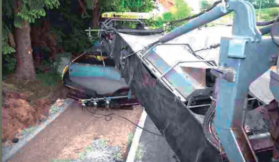
Beschickung des Straßenfertigers mittels eines „Beschickers“ (Übergabefertiger)
