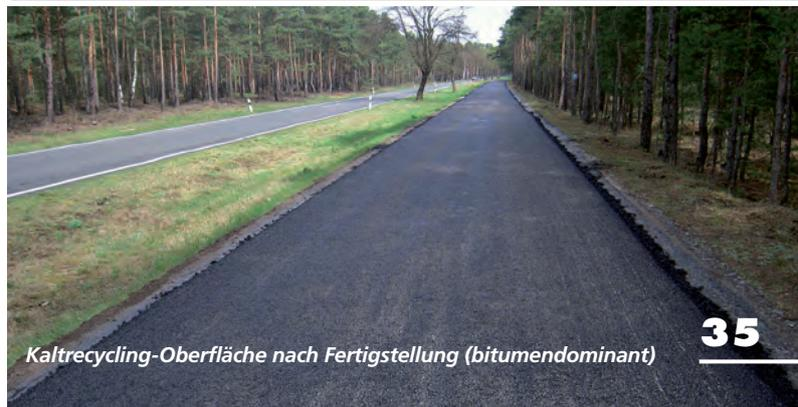
Kaltrecycling-Oberfläche nach Fertigstellung (bitumendominant)
