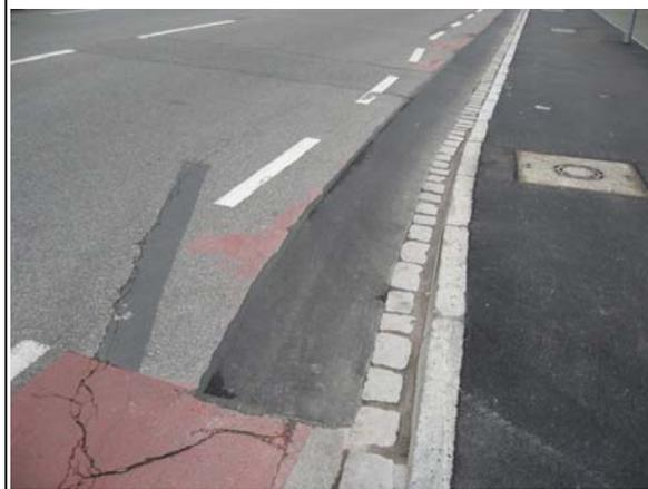
Belagsschäden im Schutzstreifen
