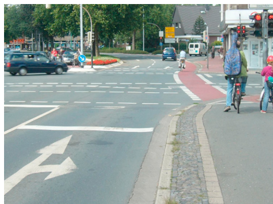
Zurücklegen der Haltlinie des an den Radweg angrenzenden Fahrstreifens vorher und nachher (Bocholt)
