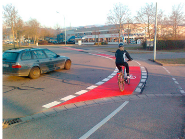
Roteinfärbung einer anliegenden Radverkehrsfurt (Freiburg)
