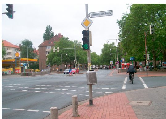
Signaltechnische Sicherung der Linksabbieger wegen zweistreifigem Kfz-Verkehr geradeaus und starkem Radverkehr auf Radweg (Hannover)
