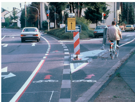
Verkleinerung Abbiegeradius für Kfz durch „Fahrradweiche“ (Troisdorf)
