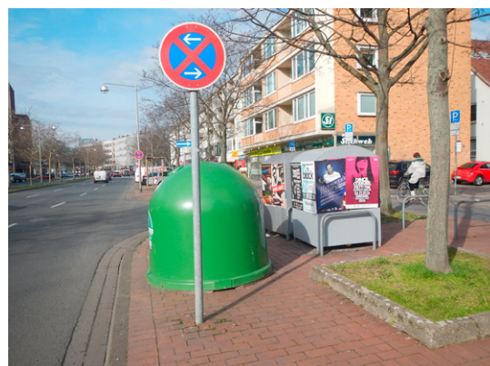
Eingeschränkte Sicht durch Recyclingcontainer bei abgesetzter Radwegführung
