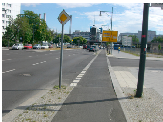
Fahrbahnahe Führung des Radweges (Berlin)
