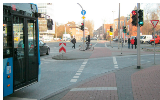
Signalisierung der Rechtsabbiegefahrbahn (Münster)
