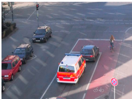
Rot eingefärbter ARAS mit Radfahrstreifen in Zufahrt (Hannover)
