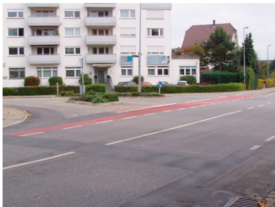
Breiter Einmündungstrichter mit zügiger Ein- und Abbiegemöglichkeit vorher (Friedrichshafen)
