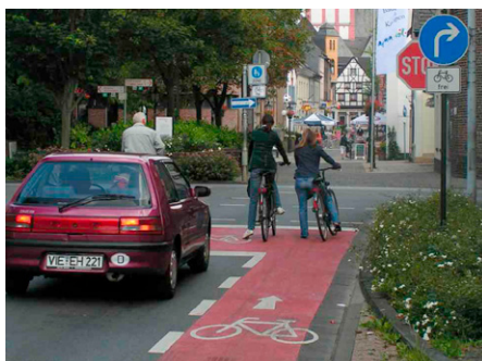
ARAS mit Zufahrt als Schutzstreifen (Kempen)
