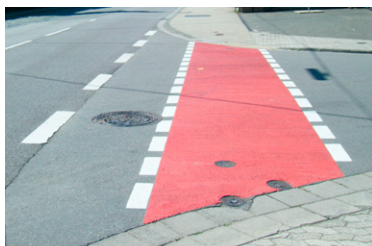
Roteinfärbung bei Gehweg mit zugelassenem Radverkehr (Dillingen)
