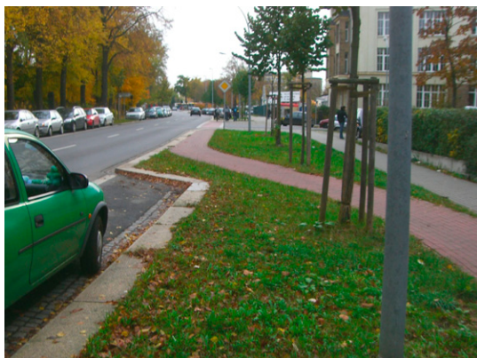
Heranführen des Radweges zur Fahrbahn (Chemnitz)
