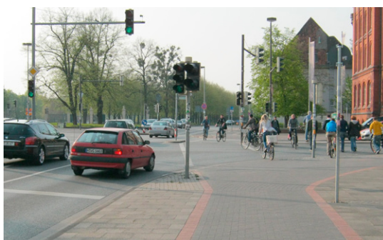
Freier Rechtsabbiegefahrbahn vor und nach Umbau (Hannover)
