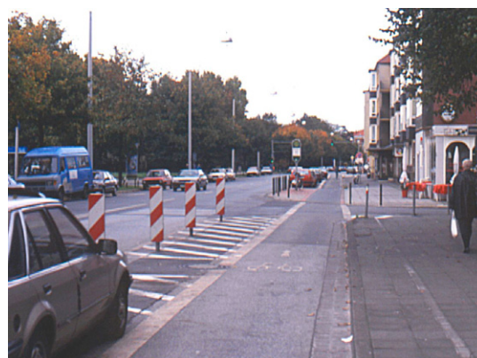
Freihalten der Sicht durch Sperrfläche mit Bake (Hannover)
