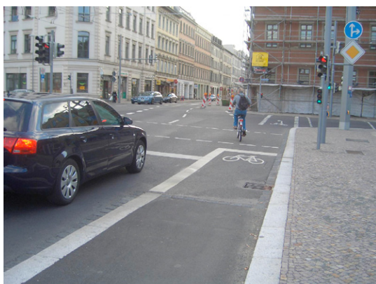
Vorlaufgrün bei Radwegende an einem Knotenpunkt (Leipzig)
