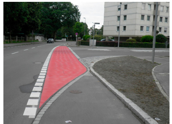
Einmündung nach deutlicher Verkleinerung des Einmündungstrichters und der Eckausrundung (Friedrichshafen)
