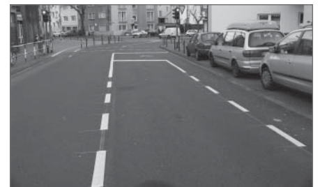
Vorgezogene Haltelinie und aufgeweitete Aufstellflächen für den Radverkehr
